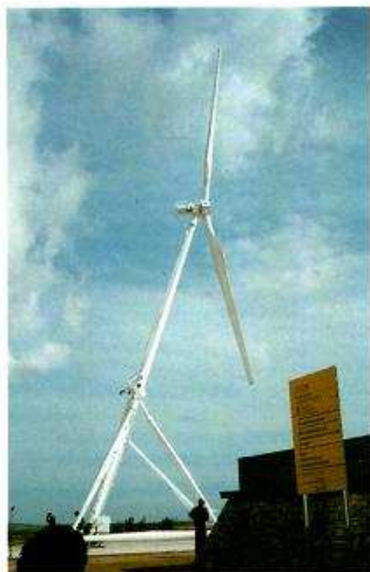
Nueva tecnología eólica para bombeo. Calaf (Barcelona).
