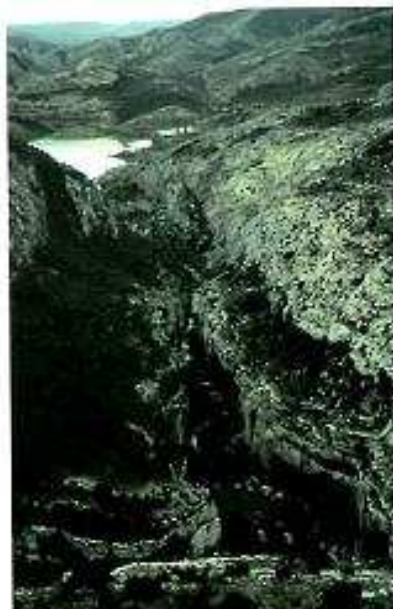
La presa de la Central Térmica de Aliaga se contruyó a la entrada de la Hoz Mala, impresionante garganta a través de la cual el Guadalupe se abre paso en las formaciones calcáreas del Cretácico superior. El roquedo calcáreo domina todo el entorno de Aliaga. Este factor, junto con las características climáticas, explican el irregular régimen hidrológico del Guadalupe y sus afluentes.
