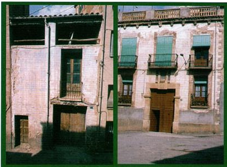
Figura 3. Fachada de Casa Navás en Cabacés. Izda.: Restos de la casa natal de L. Navás, que corresponden al detalle del plano dibujado en 1875. Dcha.: Actual Casa Navás situada enfrente de la anterior.
